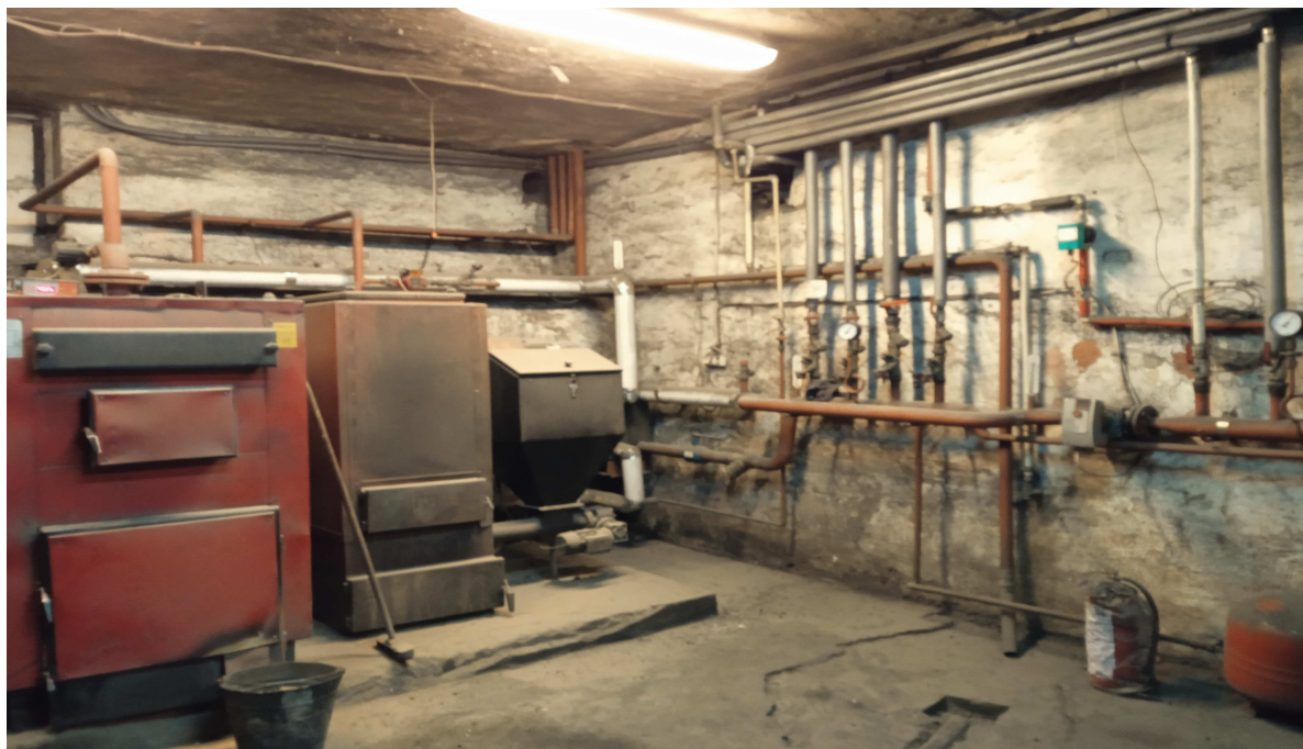
Zdj.1 Kotły na paliwo stałe przeznaczone do demontażu.
