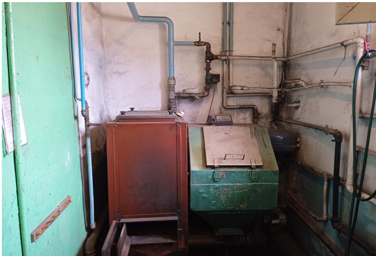
Zdj.1 Kocioł na paliwo stałe przeznaczony do demontażu.
