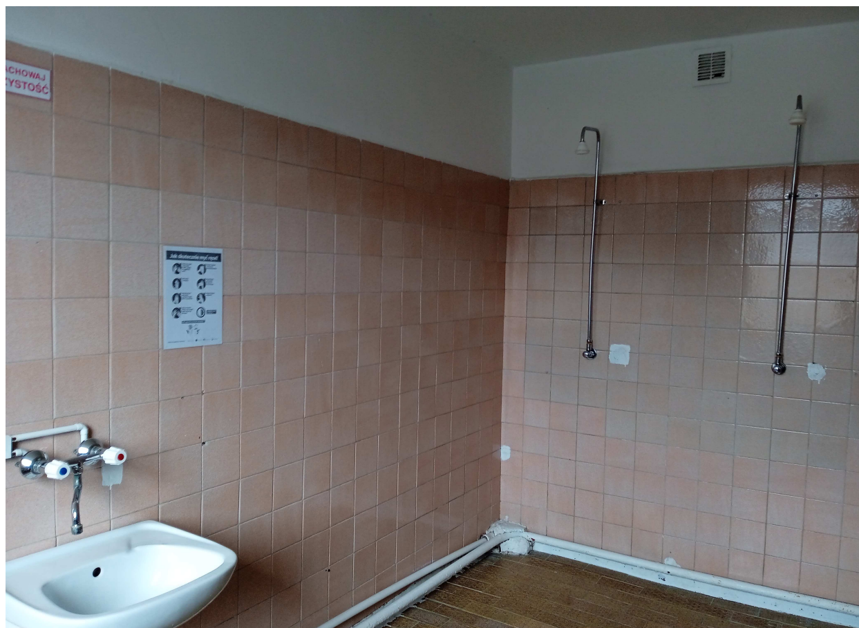
Zdj. 3 Stan istniejący - łaźnia.
